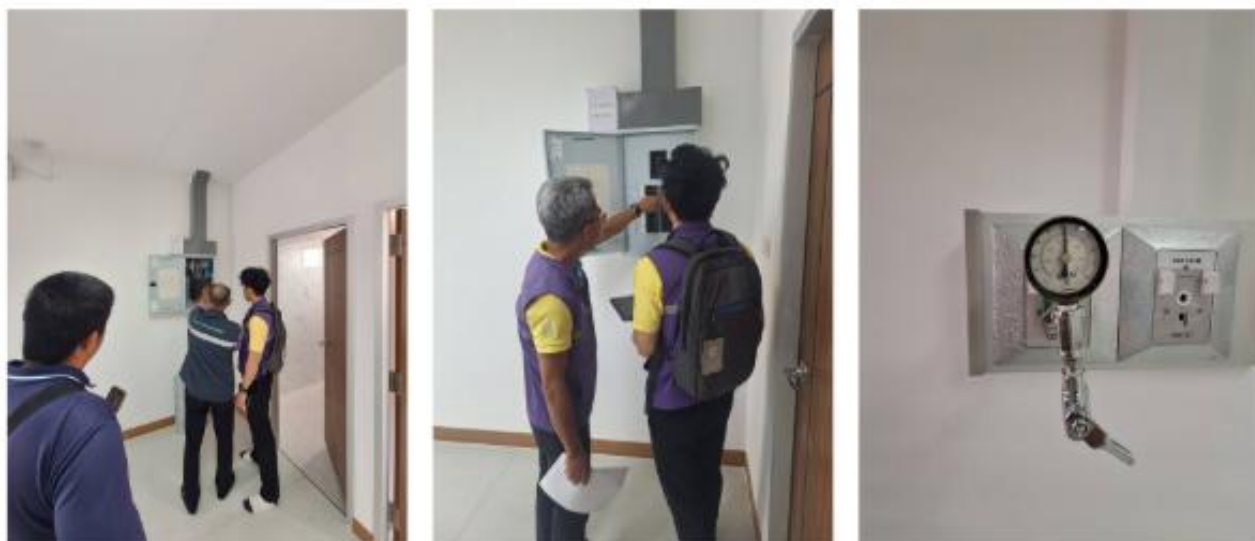
ภาพแสดงการทดสอบ ตรวจสอบระบบสัญญาณเตือนของระบบก๊าซทางการแพทย์จาก ศูนย์สนับสนุนบริการสุขภาพที่ 10 อุบลราชธานี
