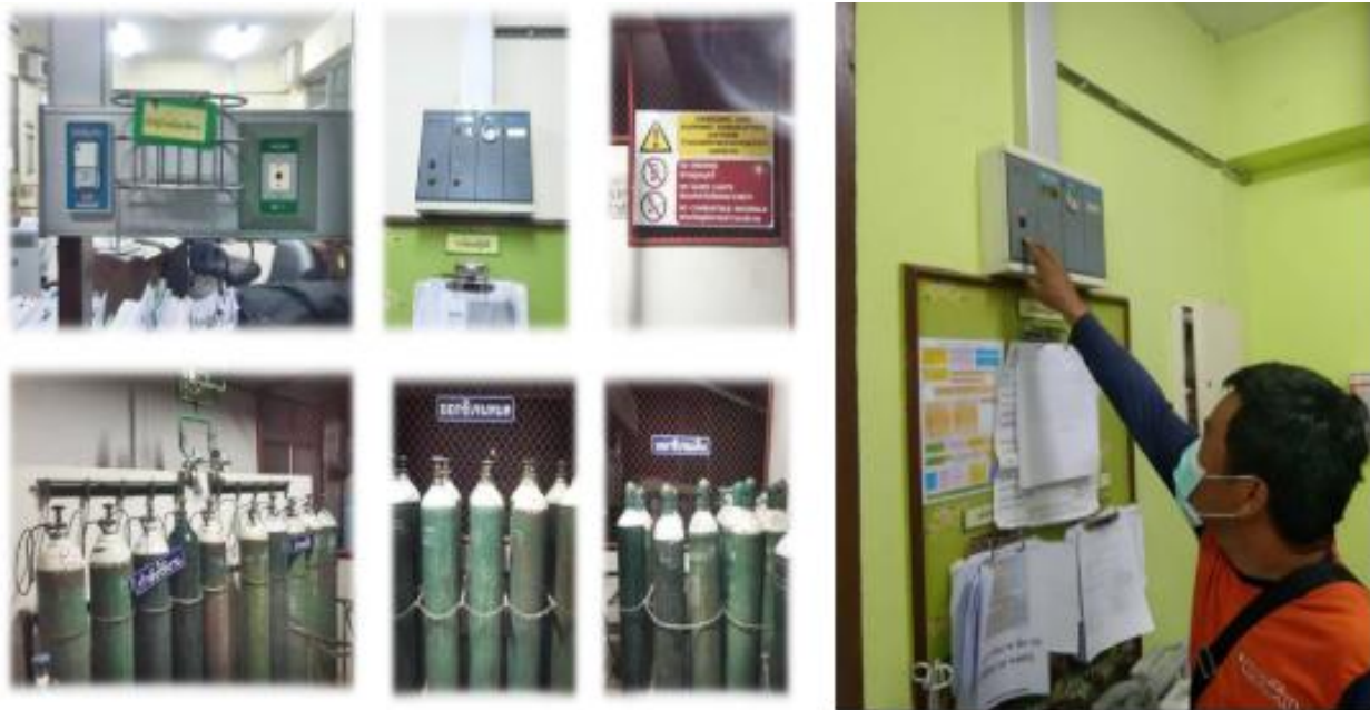
ภาพแสดงการทดสอบ ตรวจสอบระบบสัญญาณเตือนของระบบก๊าซทางการแพทย์จากเจ้าหน้าที่ของโรงพยาบาล
